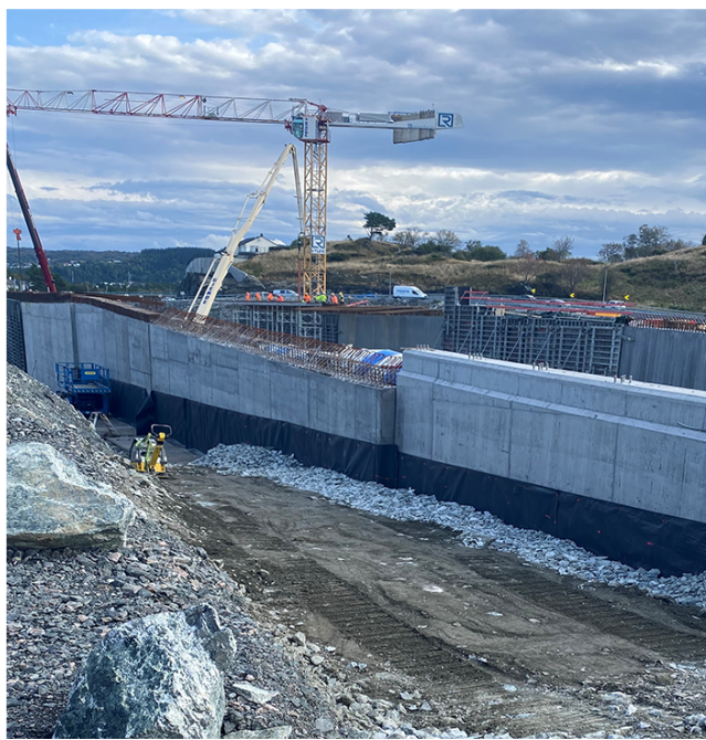
Arbeidet med fundament og vegger for mur og kulvertkonstruksjon godt i gang, og fortsetter utover høsten og vinteren. Foto: Statens vegvesen
